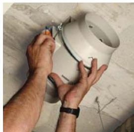
Установите блок двигатель-крыльчатка.
