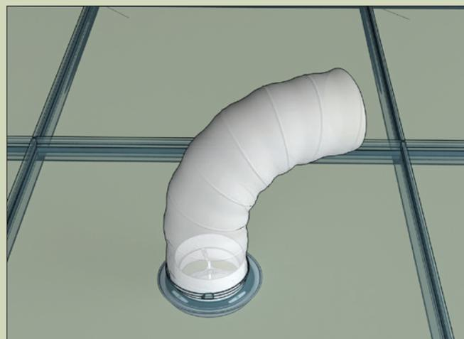
Типовой пример монтажа анемостата АПВП1 с гибким воздуховодом PF с помощью хомута и фланца Ф
