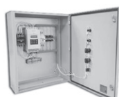
Щит (шкаф) управления типа ЩУВ, стр. 330
