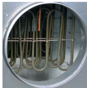
Электрический воздунагреватель Нагревательные элементы из нержавеющей стали (304L).
